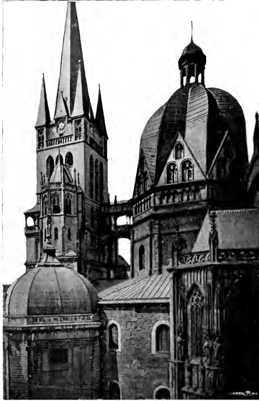
Fig. 285 - Veduta esterna della cappella palatina di Aquisgrana (a. 796-804)
